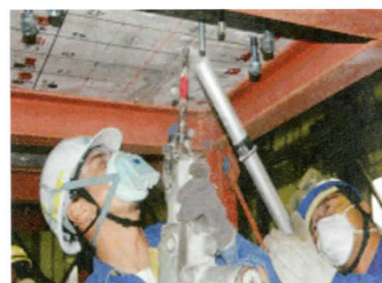
国土交通省認証の「あと施工アンカー施工技術士」資格試験では、接着系・金属拡張系アンカーともに、上向きに施工する実技試験を実施している。所定の引張耐力を上回らなければ合格できない。写真は試験官が確認している様子(写真:あと施工アンカー工事協同組合)
