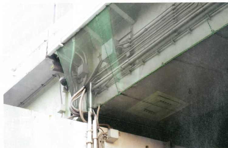
人通りや車が多い交差点をまたぐ高架橋の桁下に、ボルトなどの落下物を防ぐネットを設置している。これもフェールセーフの考え方の一つ
