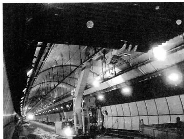
写真-1 天井板撤去中
