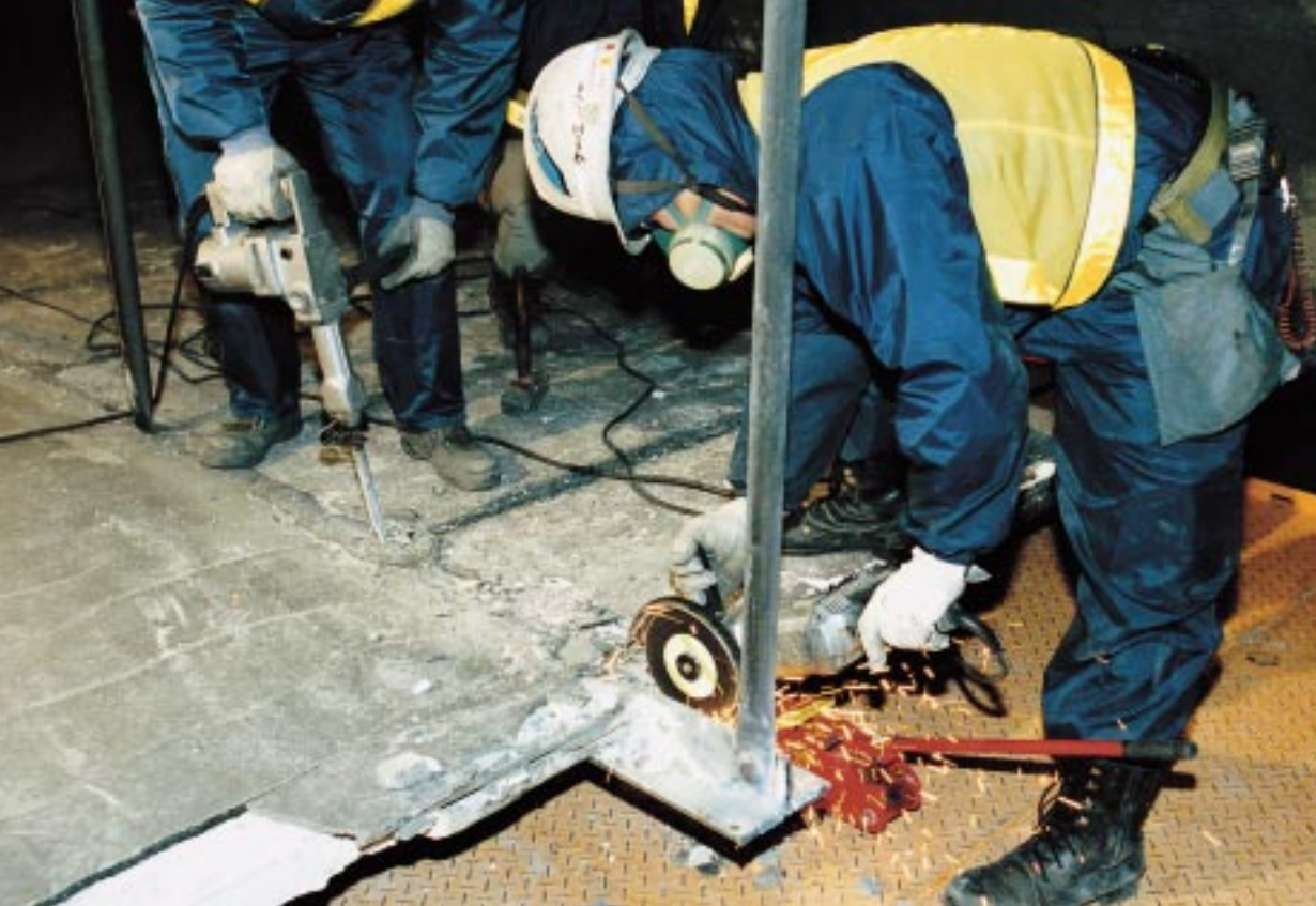
長さ2376mのトンネルの天井板をすべて取り替えた。ALC（軽量気泡コンクリート）板を使った既存の天井板を撤去し（左の写真）、セメント押し出し成形板を約8000枚据え付けた（左下の写真）。右下の写真は、天井板の工事に用いた移動式のプロテクター。2基使った
