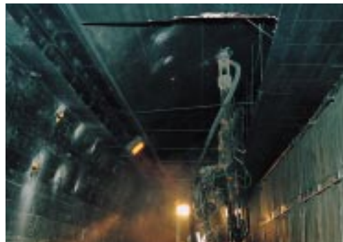
ロックボルトの打設状況。長さ4.5mのロックボルトを約3800本、使用した
