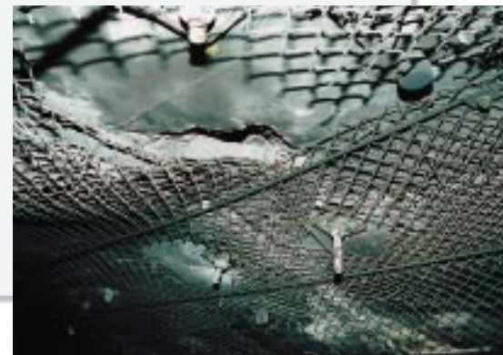
補修前のトンネル内部。覆工がひび割れている。金網は、はく落防止のために今回の補修前に取り付けていた
