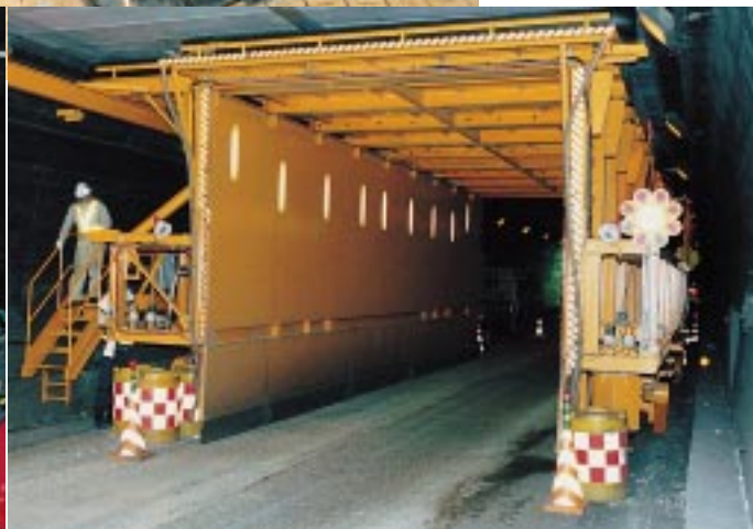
長さ2376mのトンネルの天井板をすべて取り替えた。ALC（軽量気泡コンクリート）板を使った既存の天井板を撤去し（左の写真）、セメント押し出し成形板を約8000枚据え付けた（左下の写真）。右下の写真は、天井板の工事に用いた移動式のプロテクター。2基使った
