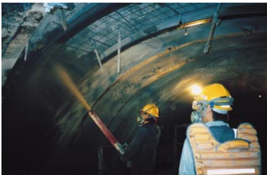
覆工の二次吹き付けの様子。金網を取り付けた部分に、コンクリートを吹き付けた
