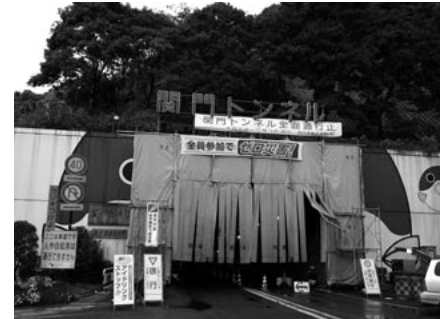
通行止め期間中の関門トンネル門司側の坑口。近くにマンションがあるので、天井板の撤去中の換気が難しかった
